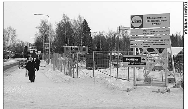
Pakilantien ilme on muuttunut roimasti vanhan liiketalon purkamisen myötä.
